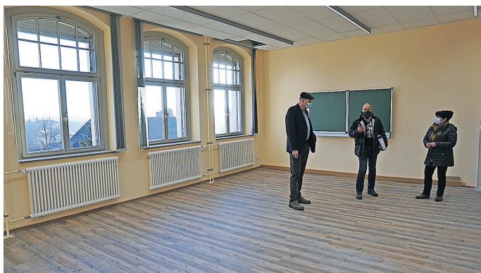
OB Olaf Raschke informiert sich vor Ort über den Stand der Sanierung. Foto: Stadt Meissen
