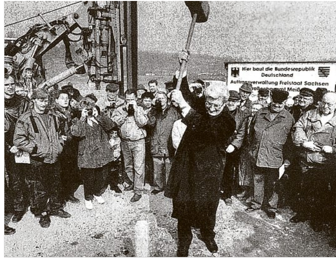
Staatssekretär Johannes Nitsch vom Bundesministerium für Verkehr schlug den ersten Holzpfehl ein und gab damit den Startschuss für den Bau der Brücke.
