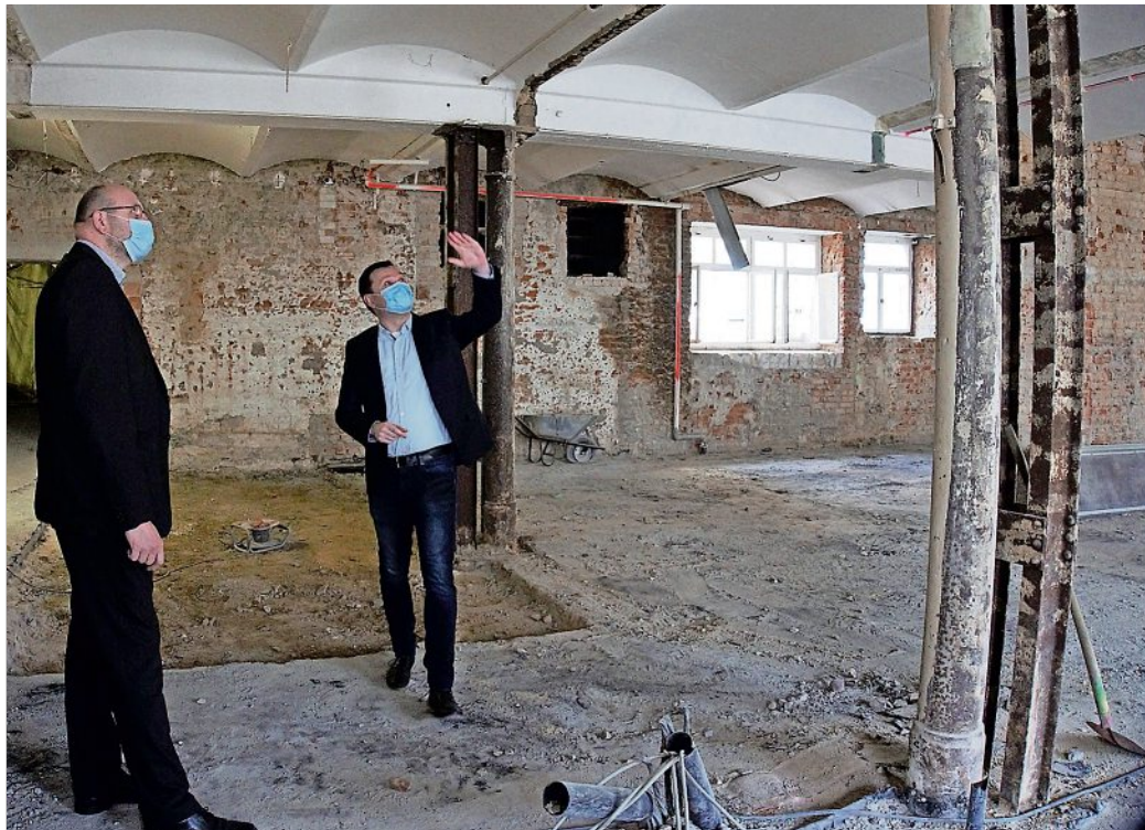
Geschäftsführer Falk Müller informiert Oberbürgermeister Olaf Raschke zum Stand der Bauarbeiten im ICM.
